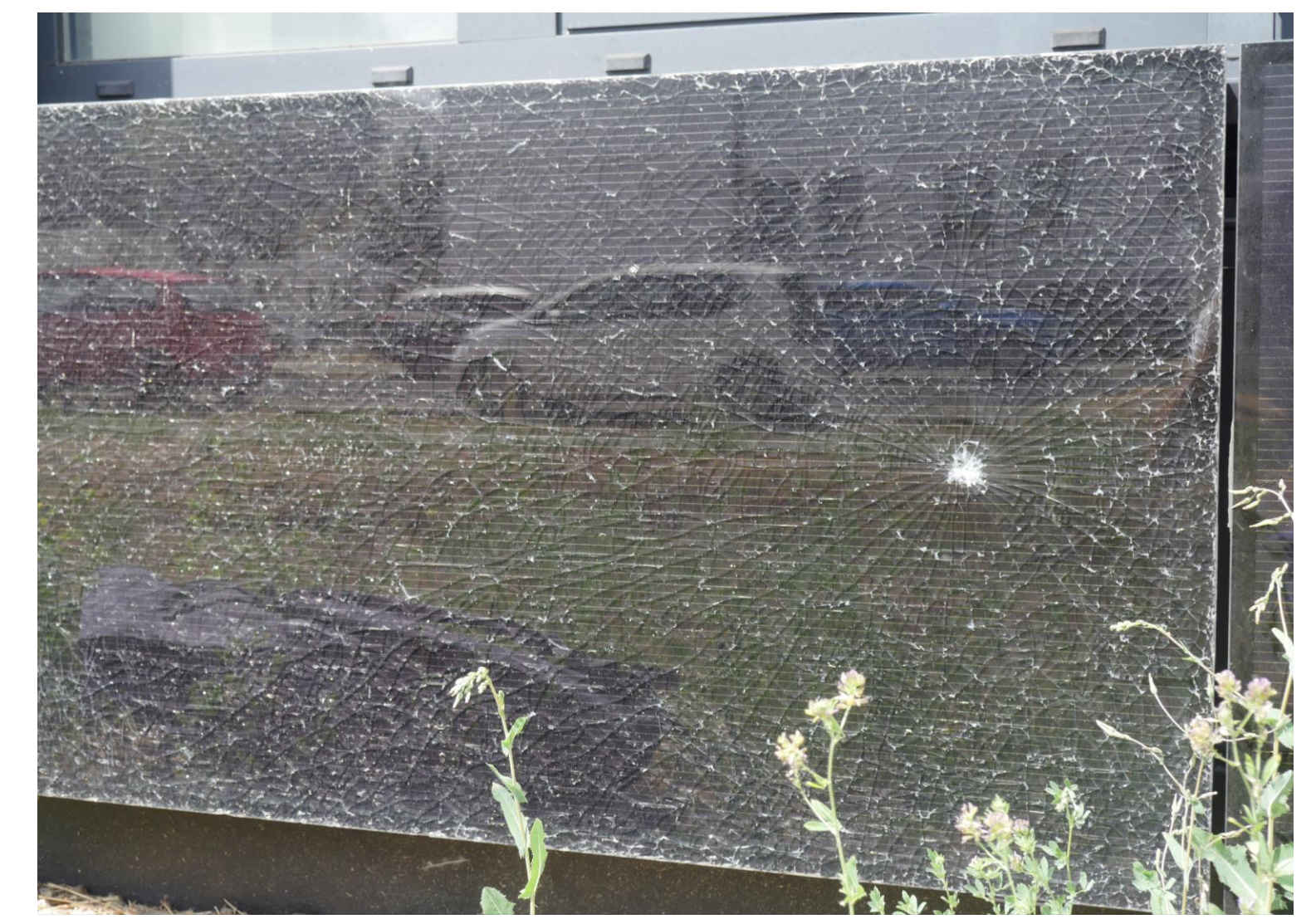
Sulfurcell Gebäude Berlin, durch Steinschlag gebrochenes CIS PV-Modul
