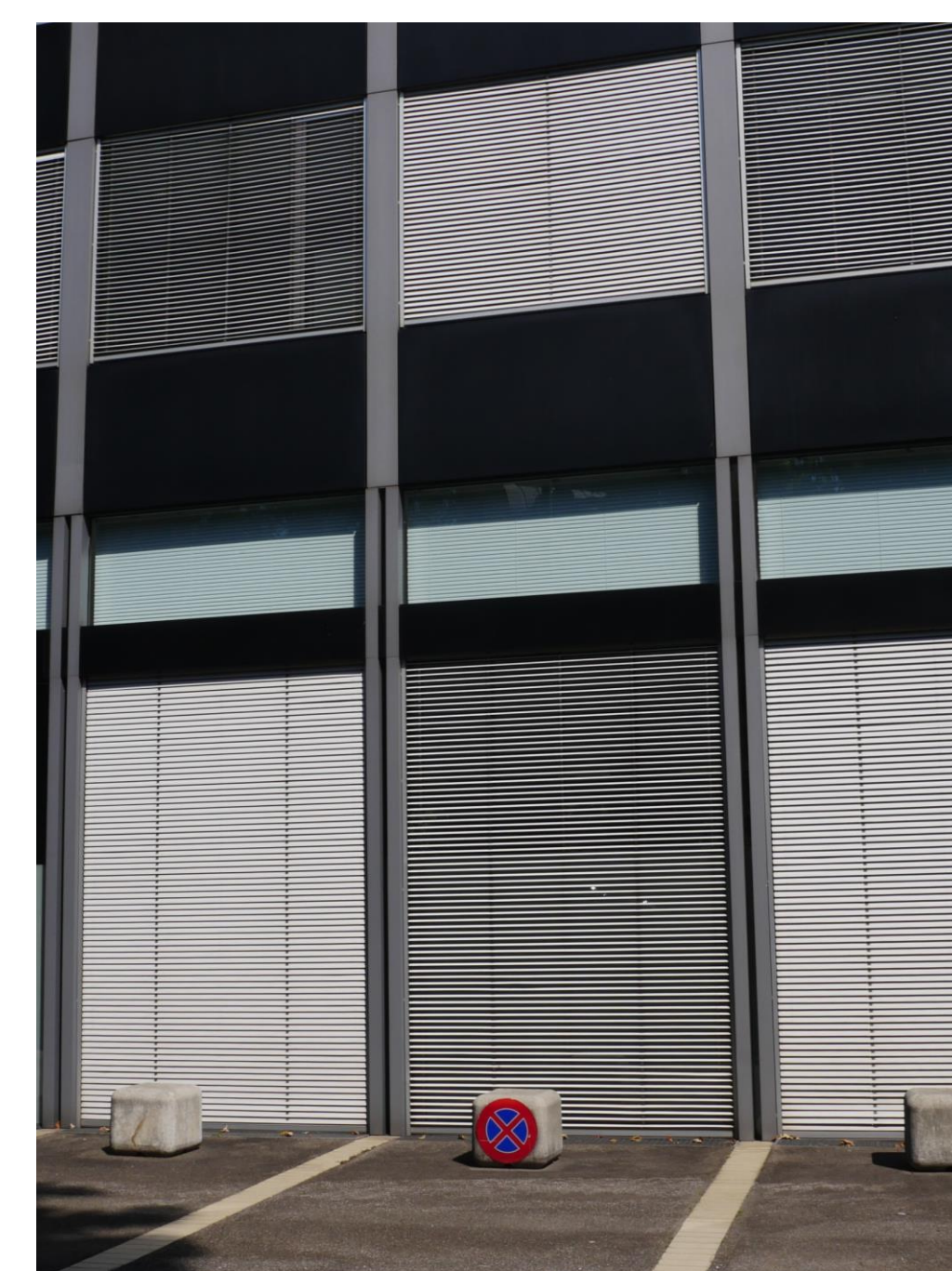
Lonza Hochhaus Basel, Schutz der Glasscheiben durch Betonpoller
