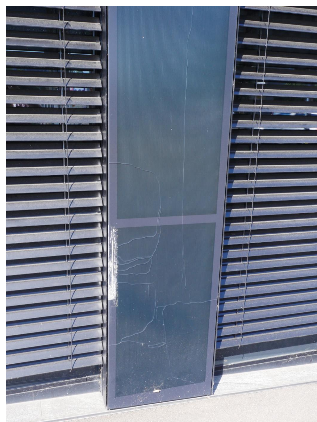
GrossPeter Tower Basel, beschädigte PV-Module wegen fehlendem und nicht ausreichendem Kantenschutz
