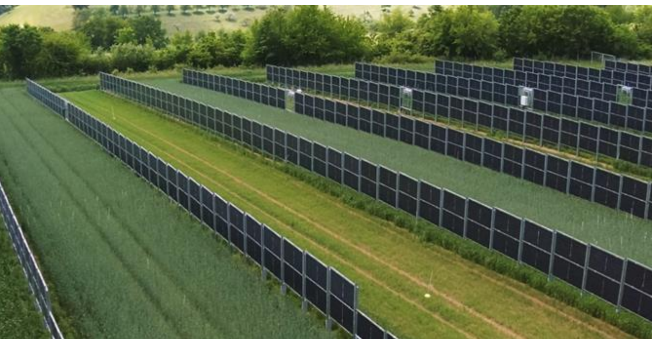
Abb. 2: Vertikales Agri-PV-System der Firma Next2Sun. Foto: S. Well, Universität Hohenheim.
