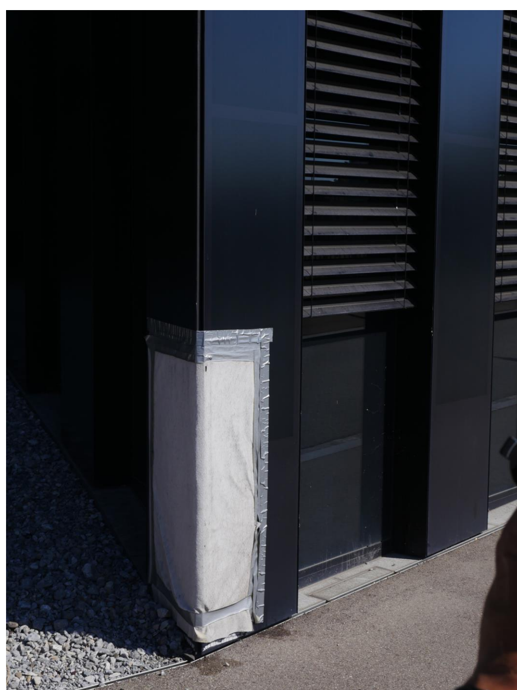
GrossPeter Tower Basel, beschädigte PV-Module wegen fehlendem und nicht ausreichendem Kantenschutz
