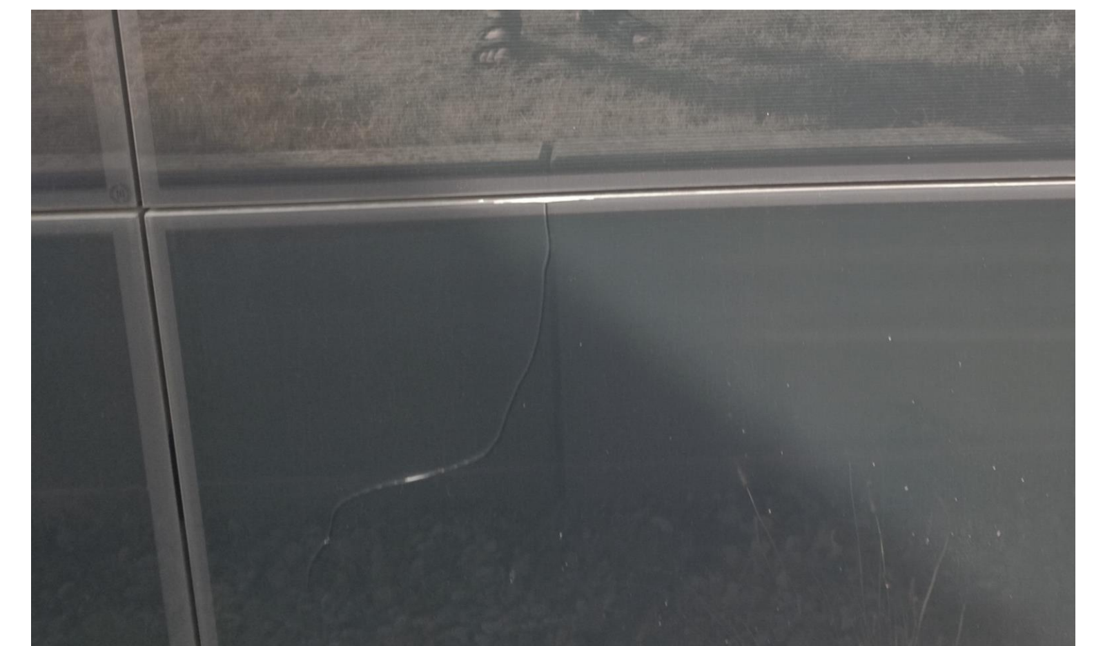
PV-Fassade des Energieeffizienzhauses Berlin; Modulbruch an den unteren CIS-Modulen wahrscheinlich durch Thermischen Bruch wegen Teilverschattung der davor stehenden Betonbrüstung.
