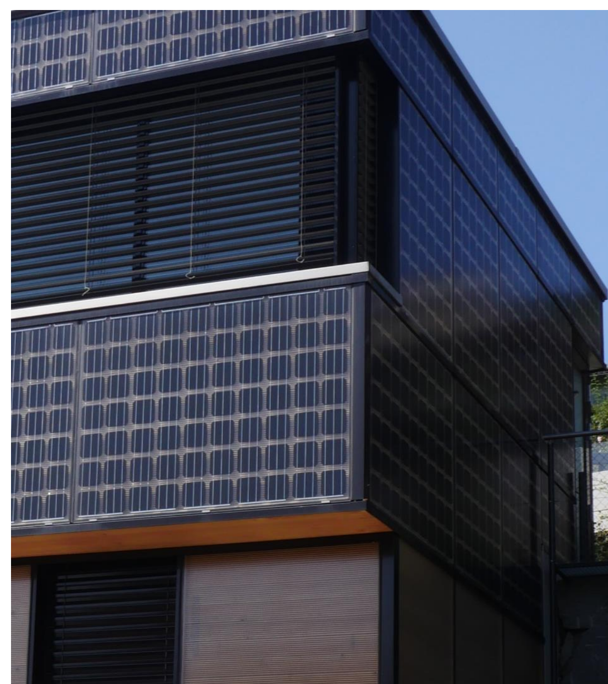
Wohnhaus Wil, Vorbildlicher Kantenschutz oben, unten und auf der Ecke
