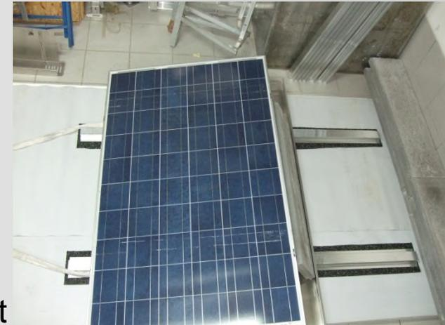
A Aluminium-Bautenschutzmatte Regupol-Dachhaut
